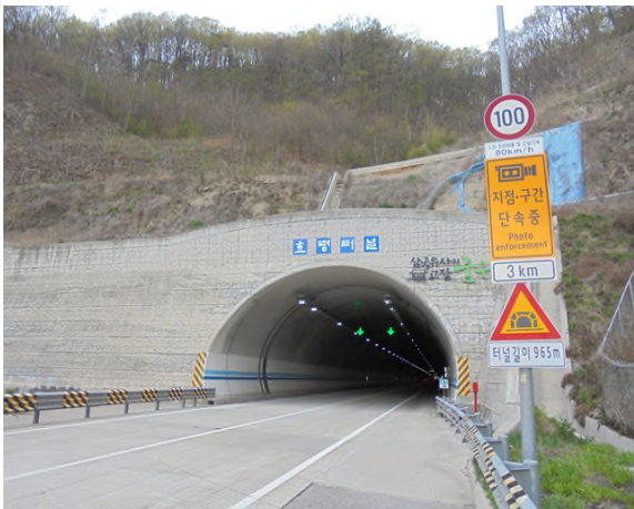
5공구 효령터널(상주방향) (5공구) 시점부
