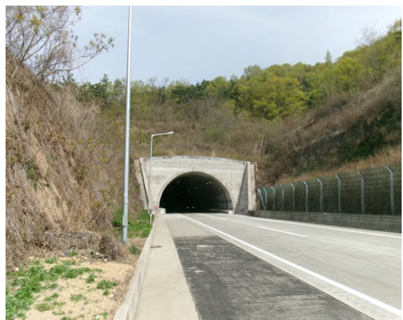
4공구 평호터널(영천방향) (4공구) 종점부
