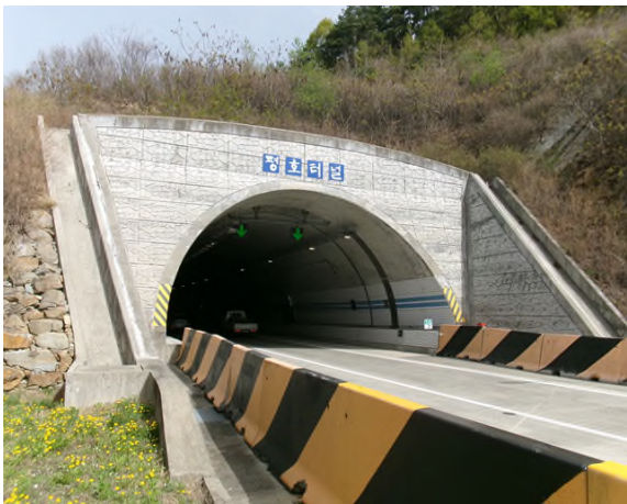
4공구 평호터널(상주방향) (4공구) 시점부
