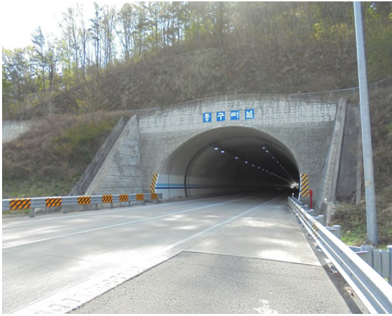
5공구 중구터널(영천) (5공구) 시점부
