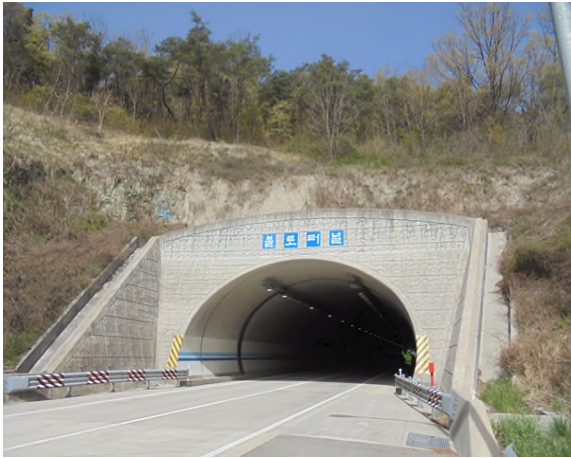
5공구 불로터널(상주) (5공구) 시점부
