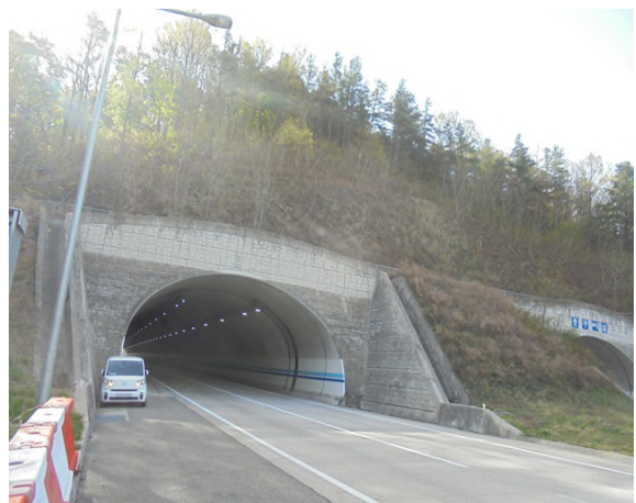
5공구 중구터널(상주) (5공구) 종점부
