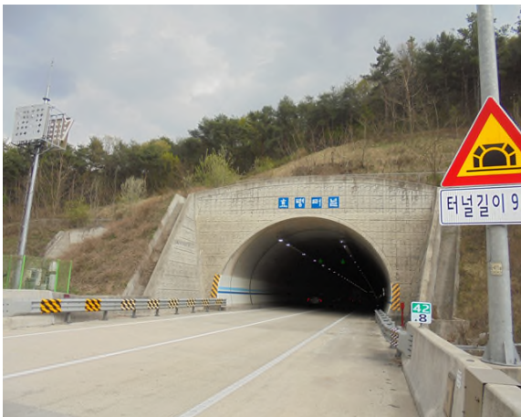
5공구 효령터널(영천방향) (5공구) 시점부
