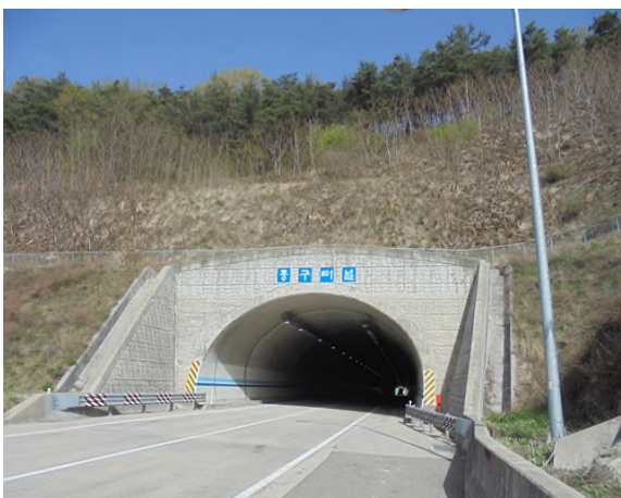
5공구 중구터널(상주) (5공구) 시점부
