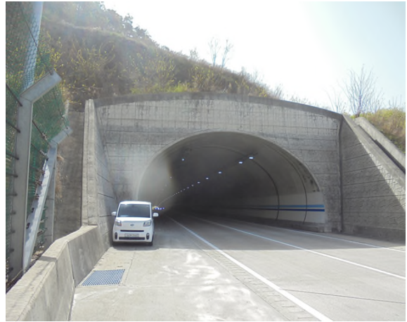
5공구 불로터널(상주) (5공구) 종점부
