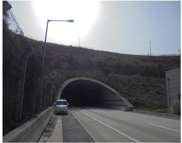
3공구 군위터널(상주방향) (3공구) 종점부
