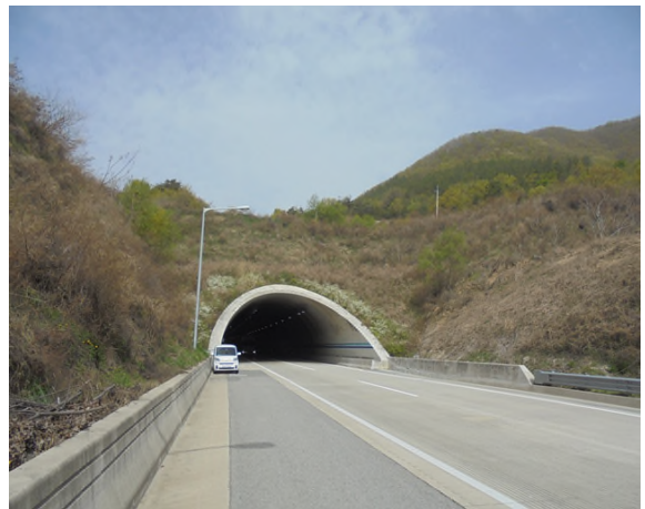
3공구 군위터널(영천방향) (3공구) 종점부
