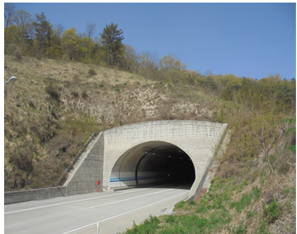
5공구 불로터널(영천) (5공구) 종점부
