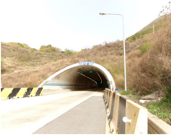
3공구 군위터널(상주방향) (3공구) 시점부
