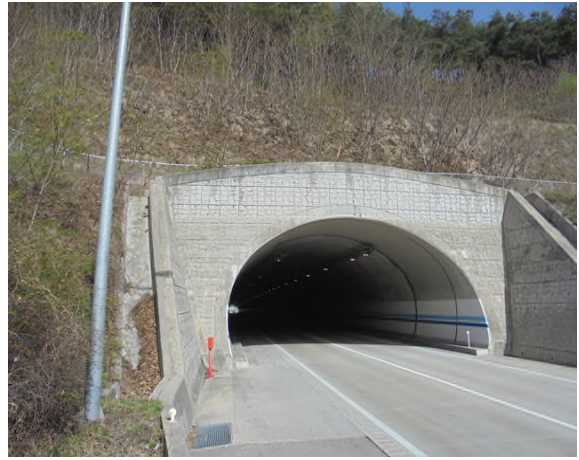
5공구 중구터널(영천) (5공구) 종점부
