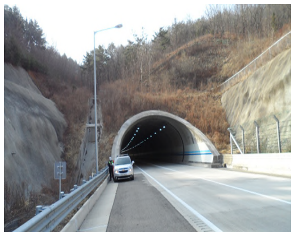
4공구 산법터널(상주방향) (4공구) 종점부
