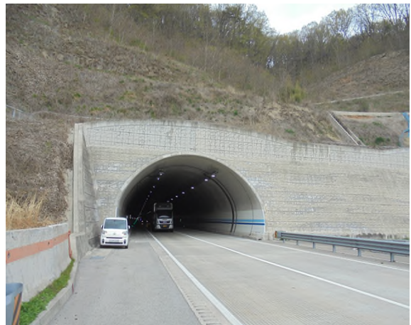
5공구 효령터널(영천방향) (5공구) 종점부
